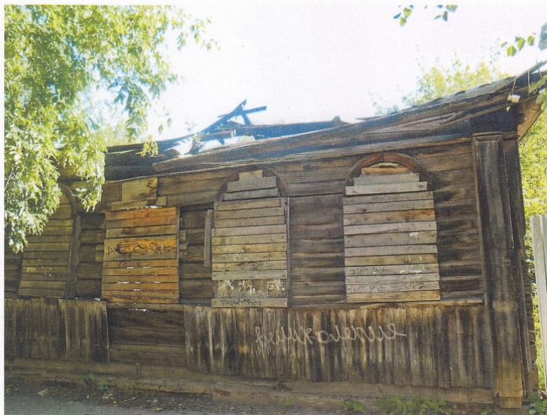
Фото 1. Фрагмент главного (западного) фасада
