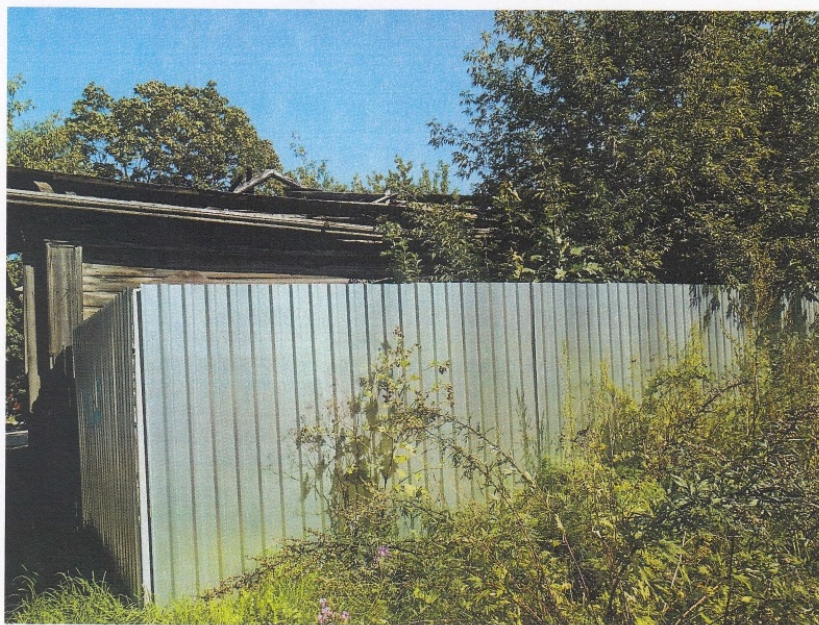
Фото 3 Фрагмент бокового (южного) фасада
