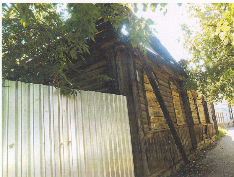
Фото 2. Фрагмент бокового (северного) и главного (западного) фасадов
