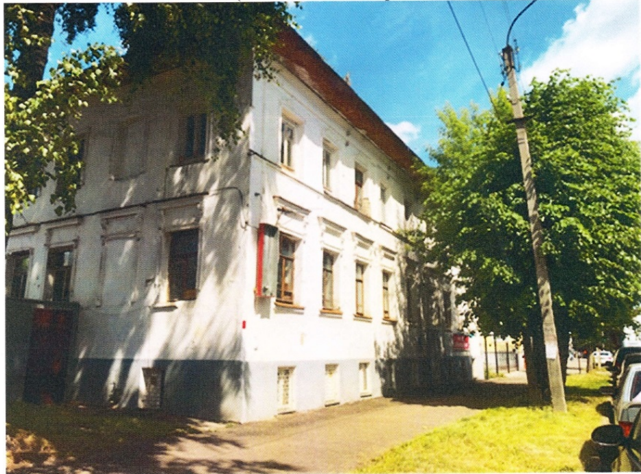
Фото 1. «Дом жилой Благовещенского», нач. XIX в., местонахождение: г. Кострома, ул. Горная, д.4. Общий вид.
