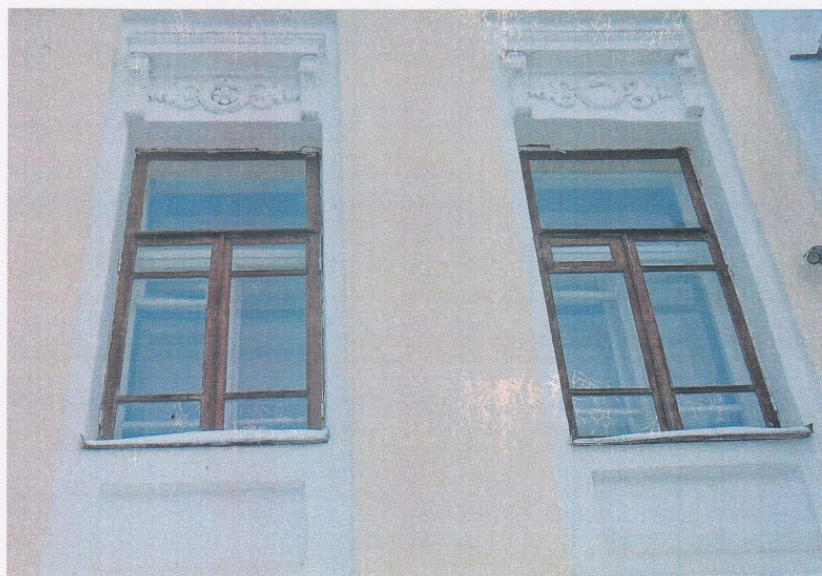
Фото 6. Фрагмент оконных проемов с декоративными элементами
