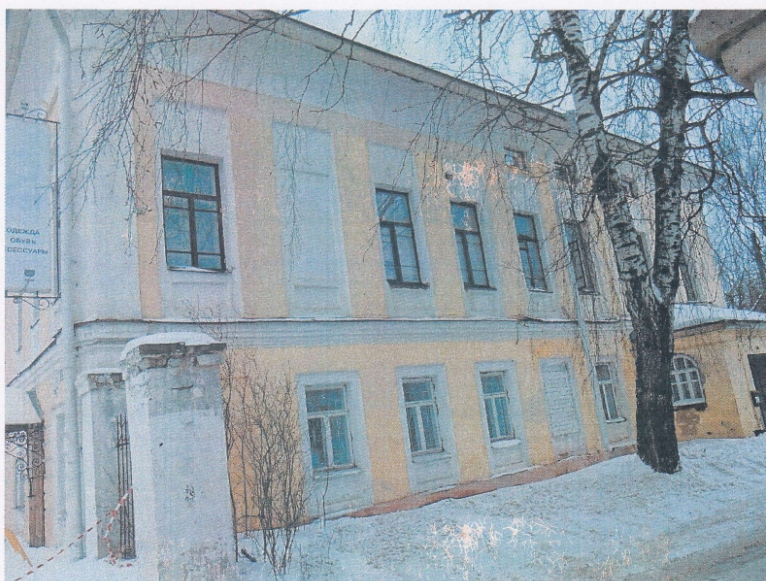
Фото 4. Вид со стороны бокового (южного) фасада
