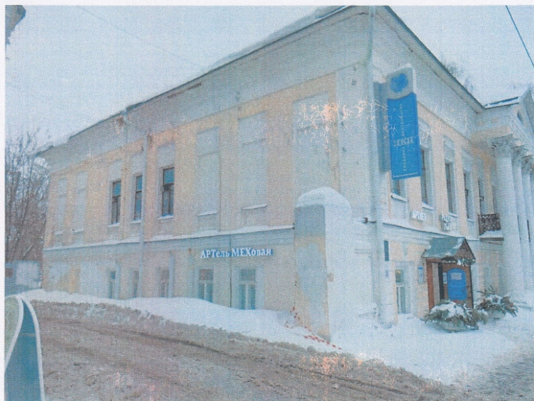
Фото 3. Вид со стороны бокового (северного) фасада
