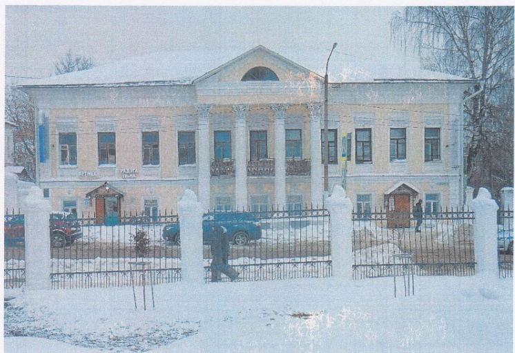
Фото 2. Вид со стороны главного (восточного) фасада
