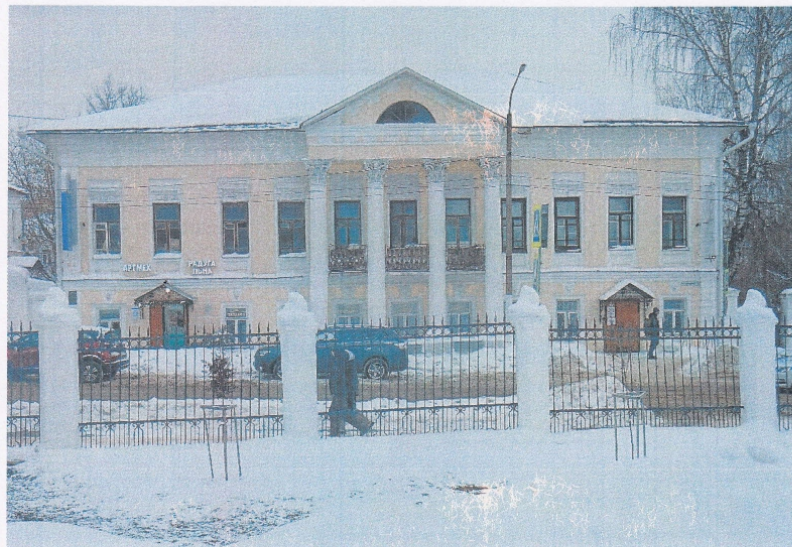
Фото 2. Вид со стороны главного (восточного) фасада
