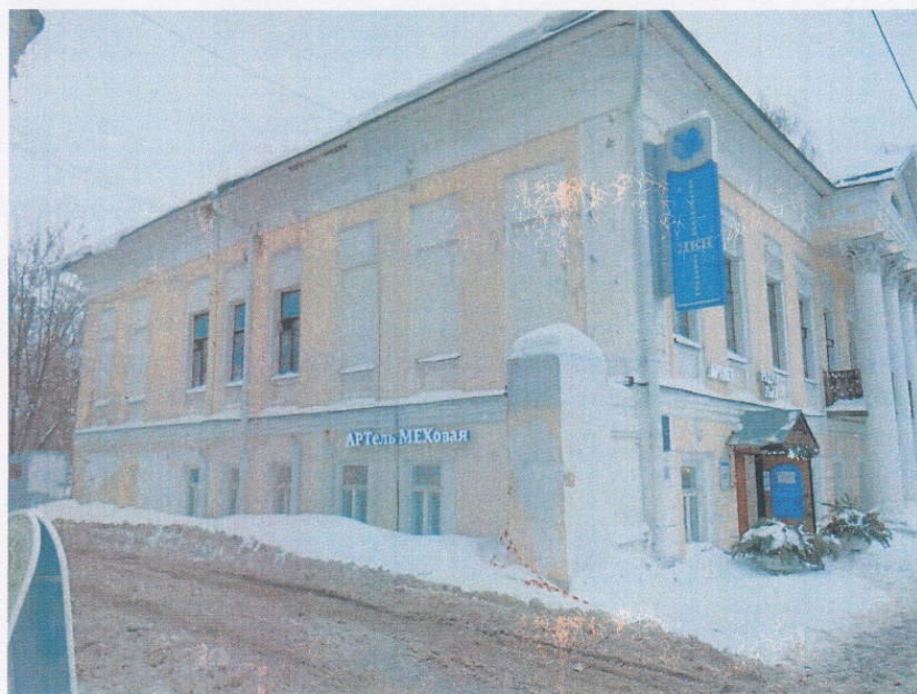
Фото 3. Вид со стороны бокового (северного) фасада
