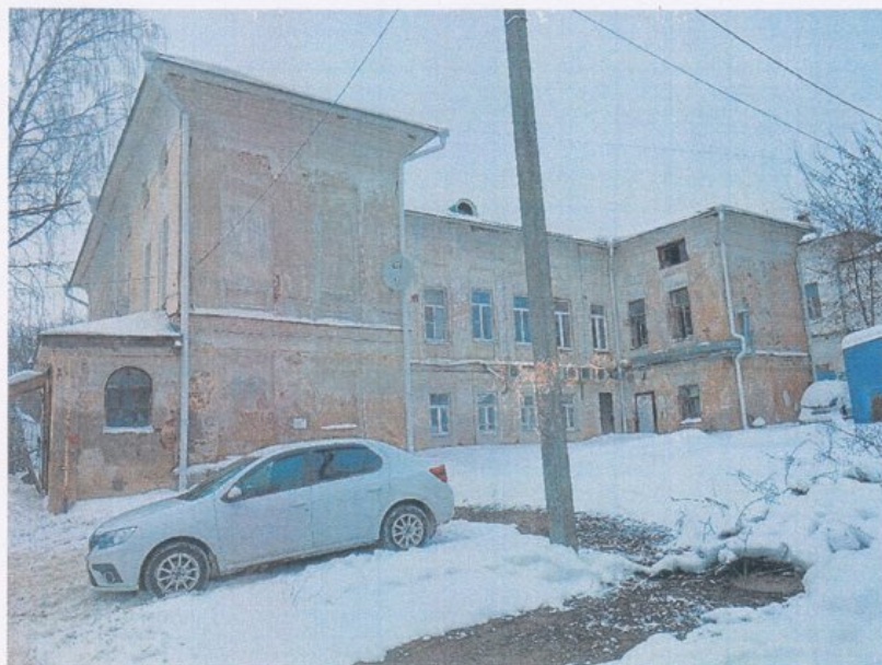
Фото 5. Вид со стороны дворового (западного) фасада
