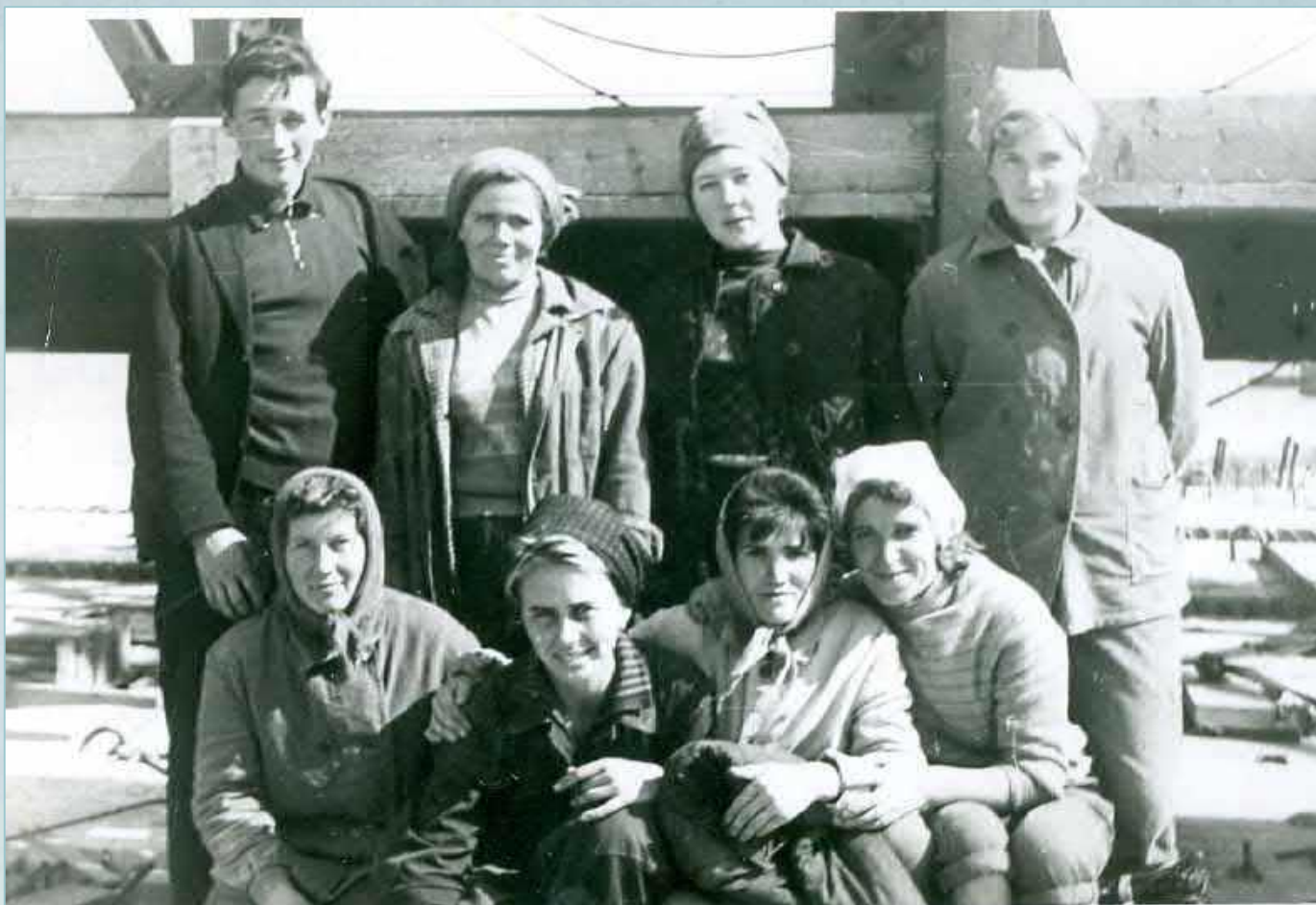
На снимке – бригада бетонщиков на строительстве моста через р. Волга. 1968 год. Н. В. Лебедева - в верхнем ряду третья слева
