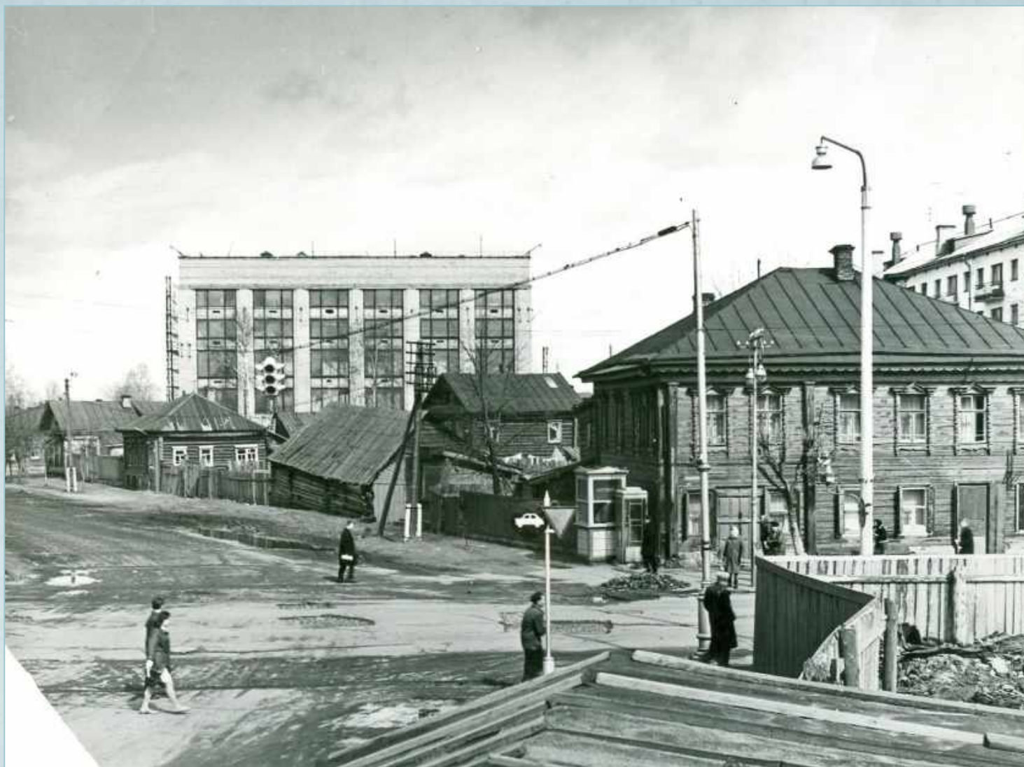
Площадь Октябрьская до реконструкции
