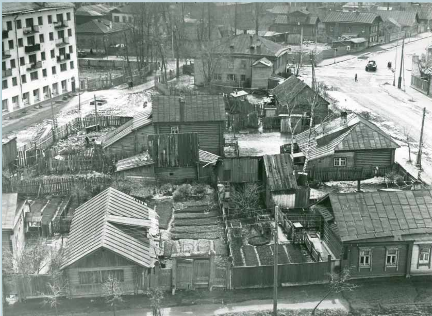
Вид на перекресток улиц Советской, Ивана Сусанина, Подлипаева до строительства моста
