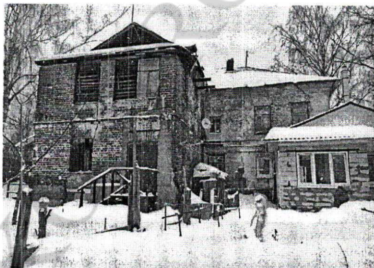
Фото 4. Вид со стороны бокового (юго-западного) фасада по левому флангу
