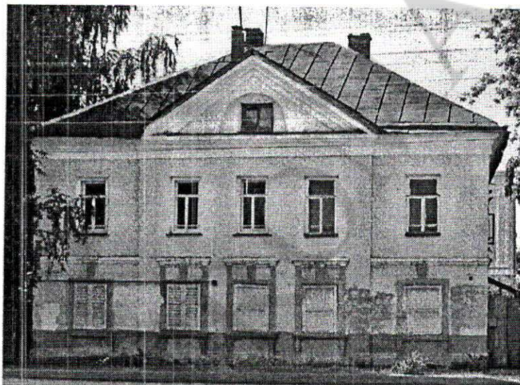
Фото 1. Вид со стороны главного (северо-восточного) фасада
