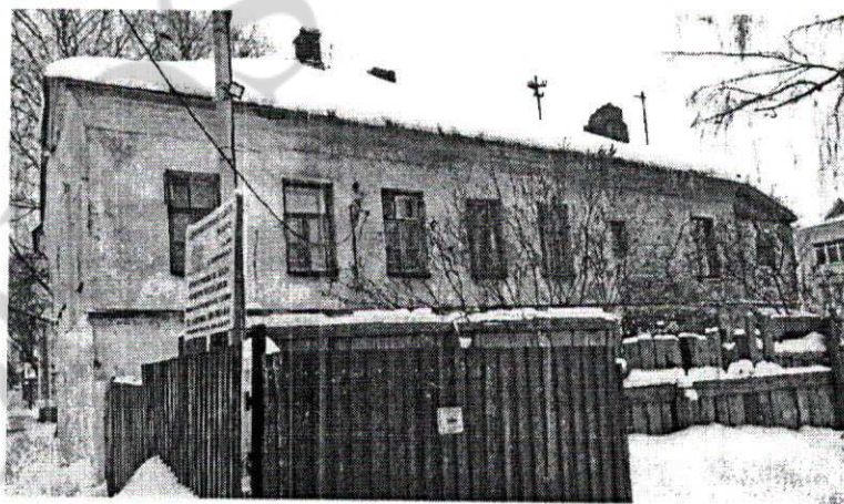
Фото 2. Вид со стороны бокового (северо-западного) фасада
