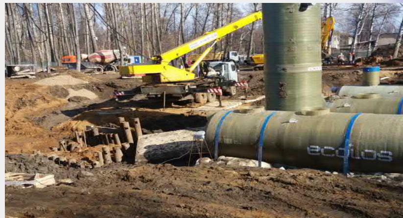
Очистные сооружения, улица Судостроительная
