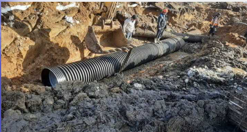
Очистные сооружения, река Алка
