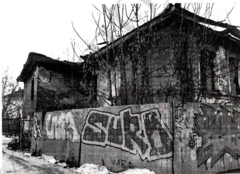
Фото 4. Вид со стороны бокового (западного) фасада
