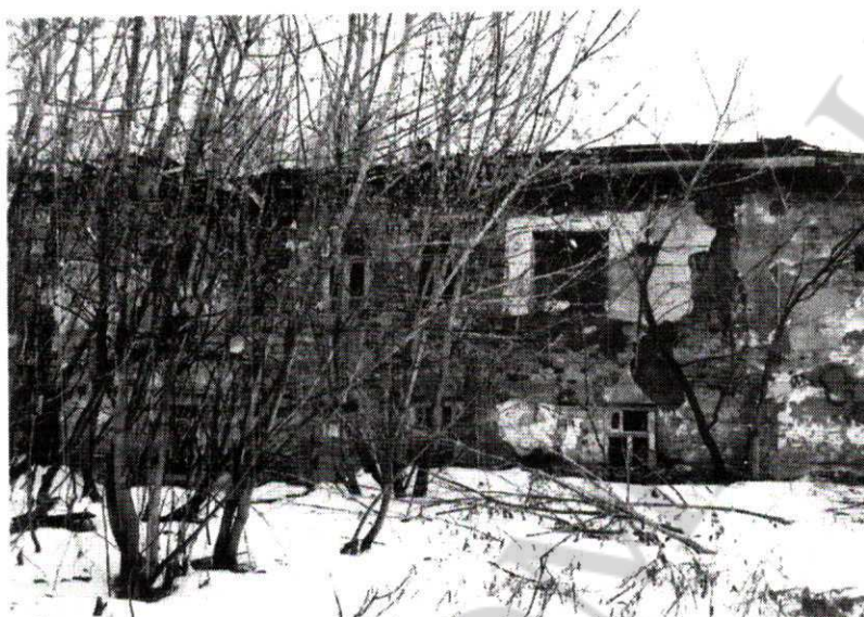
Фото 5. Вид со стороны дворового (северного) фасада
