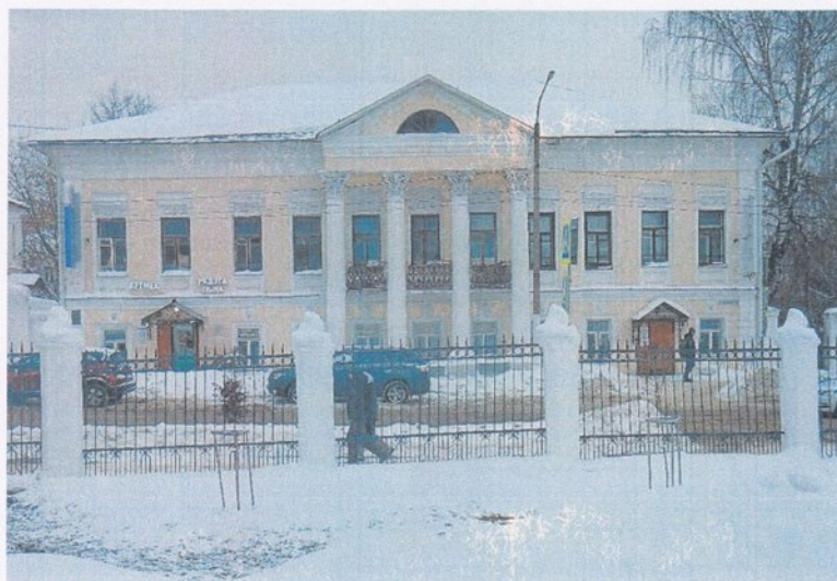
Фото 2. Вид со стороны главного (восточного) фасада
