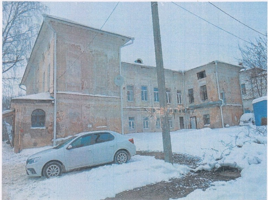
Фото 5. Вид со стороны дворового (западного) фасада
