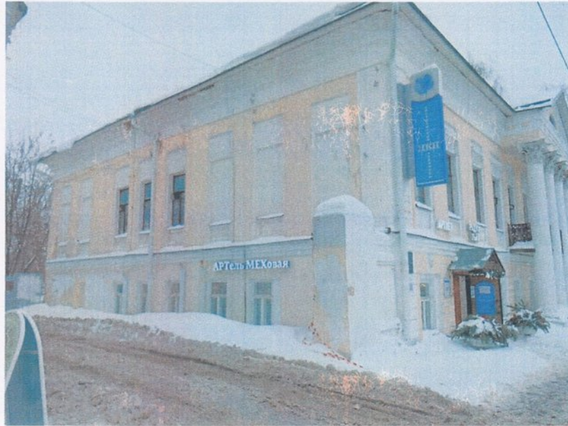
Фото 3. Вид со стороны бокового (северного) фасада
