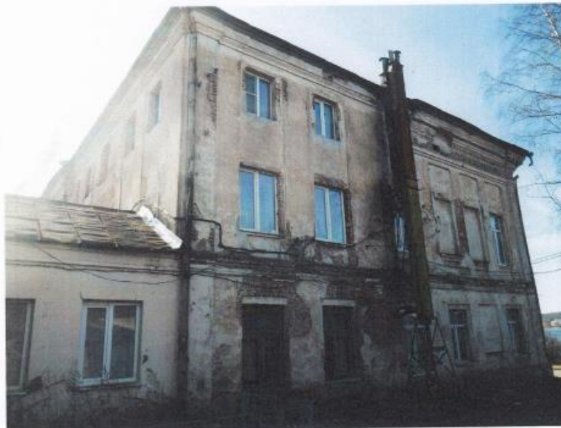
Фото 4. Вид со стороны бокового (северо-западного) фасада
