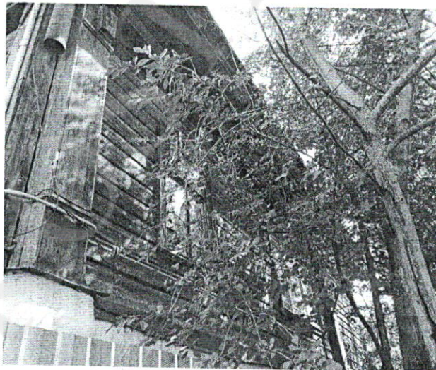
Фото 2. Боковой (южный) фасад
