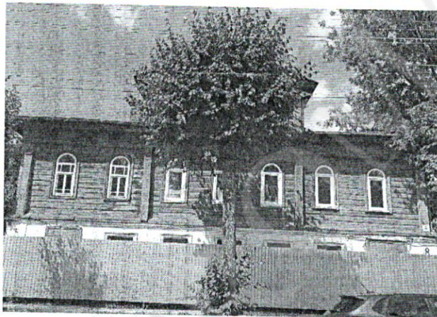
Фото 1. Главный (восточный) фасад
