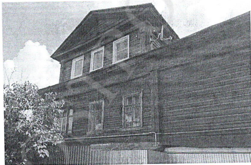
Фото 4. Дворовый (западный) фасад
